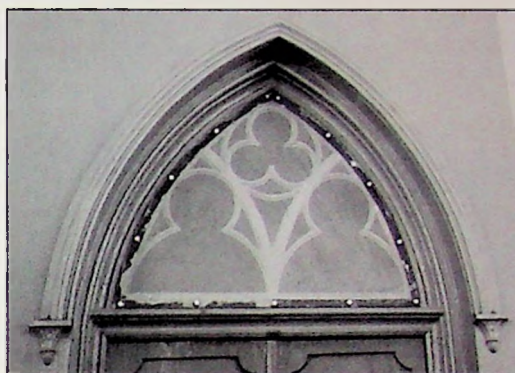
Detail van het neo-gotische bovenlicht van de toegangsdeur
