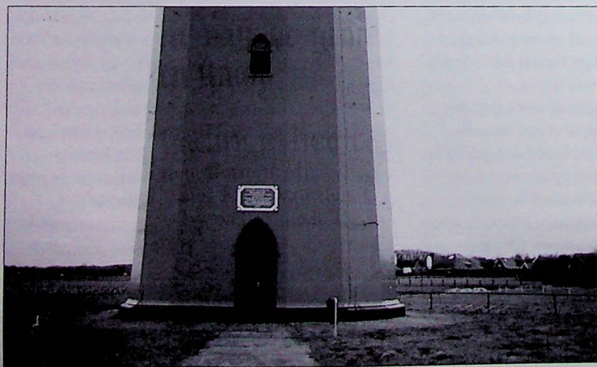
Toegang tot en fundament van lichttoren "Lange Jaap"
