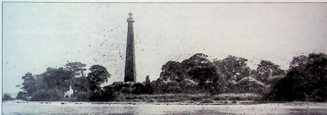
Eén van de scheppingen van Harder in het voormalige Nederlands Oost-Indië. De vuurtoren op het eilandje Edam, vlak voor de kust van Jakarta (Batavia). Deze 12-zijdige (hoekige) vuurtoren kwam in 1879 tot stand. De ijzergieter was de firma Nering Bögel.
