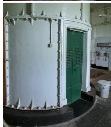
Het interieur van de Lange Jaap. De buitenschacht is hoekig, de binnenschacht rond.
