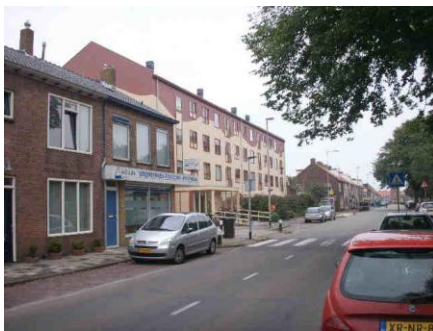
Dit gebouw aan de Willem Barentszstraat vormt door contrasterend kleur- en materiaalgebruik geen eenheid meer met zijn omgeving.
