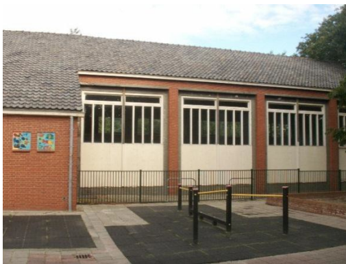
Het gymzaaltje van de openbare school aan de Duinroosstraat 2; de verticale stijlen zijn in het gehele ontwerp doorgevoerd.
