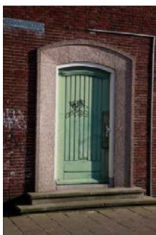
Het gymnastiekgebouwtje aan de Pasteurstraat uit 1953
