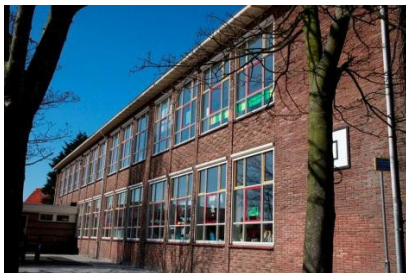
Thorbeckeschool aan de Californiëstraat
