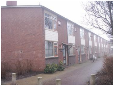
Voormalige duplexwoningen, gevelindeling boven en beneden gelijk
