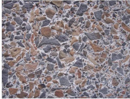
Lijst rond entree deur van gymnastieklokaaltje aan de Pasteurstraat, gemaakt van oorlogspuin. Rechts detailopname.
