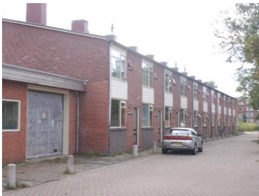
Woningen met een identieke verdeling op begane grond en verdieping verraden dat zij vroeger duplexwoningen waren
