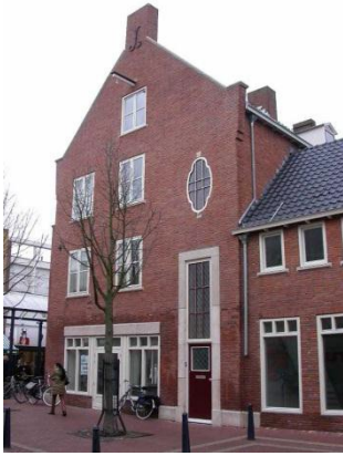
Eén van de traditionele “aanhelingen”: Breewaterstraat / hoek Spoorstraat
