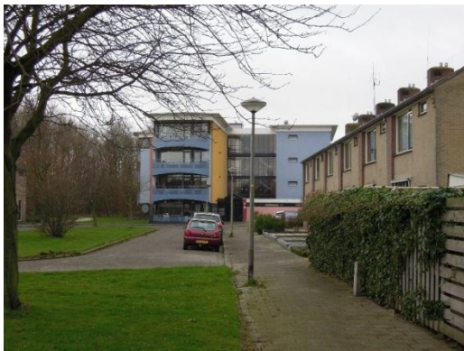
De "sterflats" na renovatie
