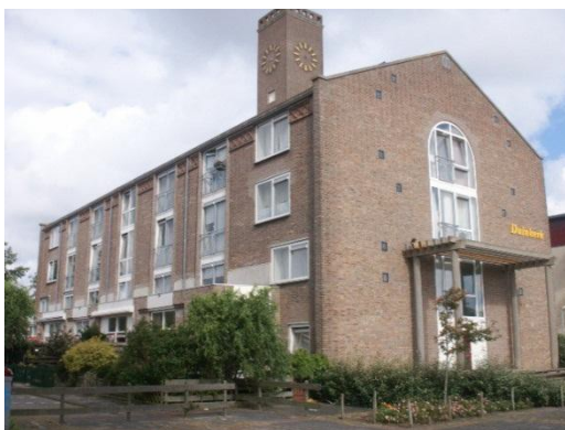
De Duinkerck als bouwmassa markant in Nieuw Den Helder West
