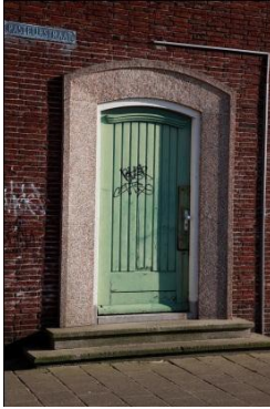
Lijst rond entree deur van gymnastieklokaaltje aan de Pasteurstraat, gemaakt van oorlogspuin. Rechts detailopname.
