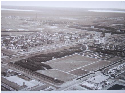
Het Kennedypark oostelijk van de Jan Verfaillweg begin jaren '60
