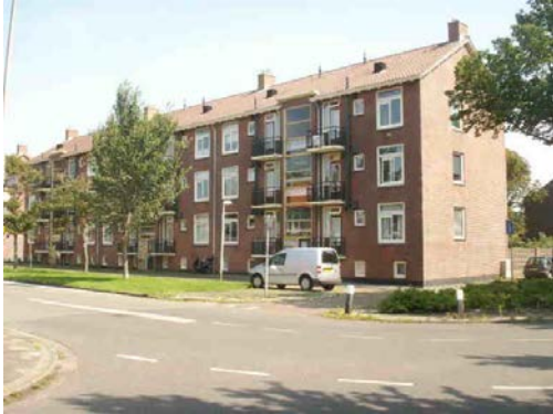
Aan de oostzijde van de Willem Barentszstraat (1952-54) staan portiekflats; zijn als type gebouw destijds vernieuwend, maar nog afgedekt met het traditionele zadeldak
